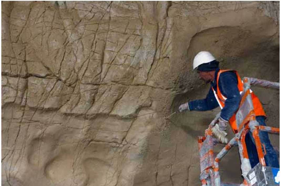
Les sculpteurs interviennent ensuite sur le mortier pour lui donner du relief, travailler sa forme, creuser des failles en se fiant au « carnet de facies », réalisé par les géomorphologues du laboratoire Edytem, pour être au plus proche de la réalité (couleurs, textures, matières spécifiques). © SYCPA – Sébastien Gayet
